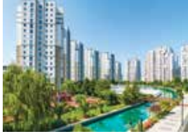
İstanbul Avrupa Konutları Atakent 3
